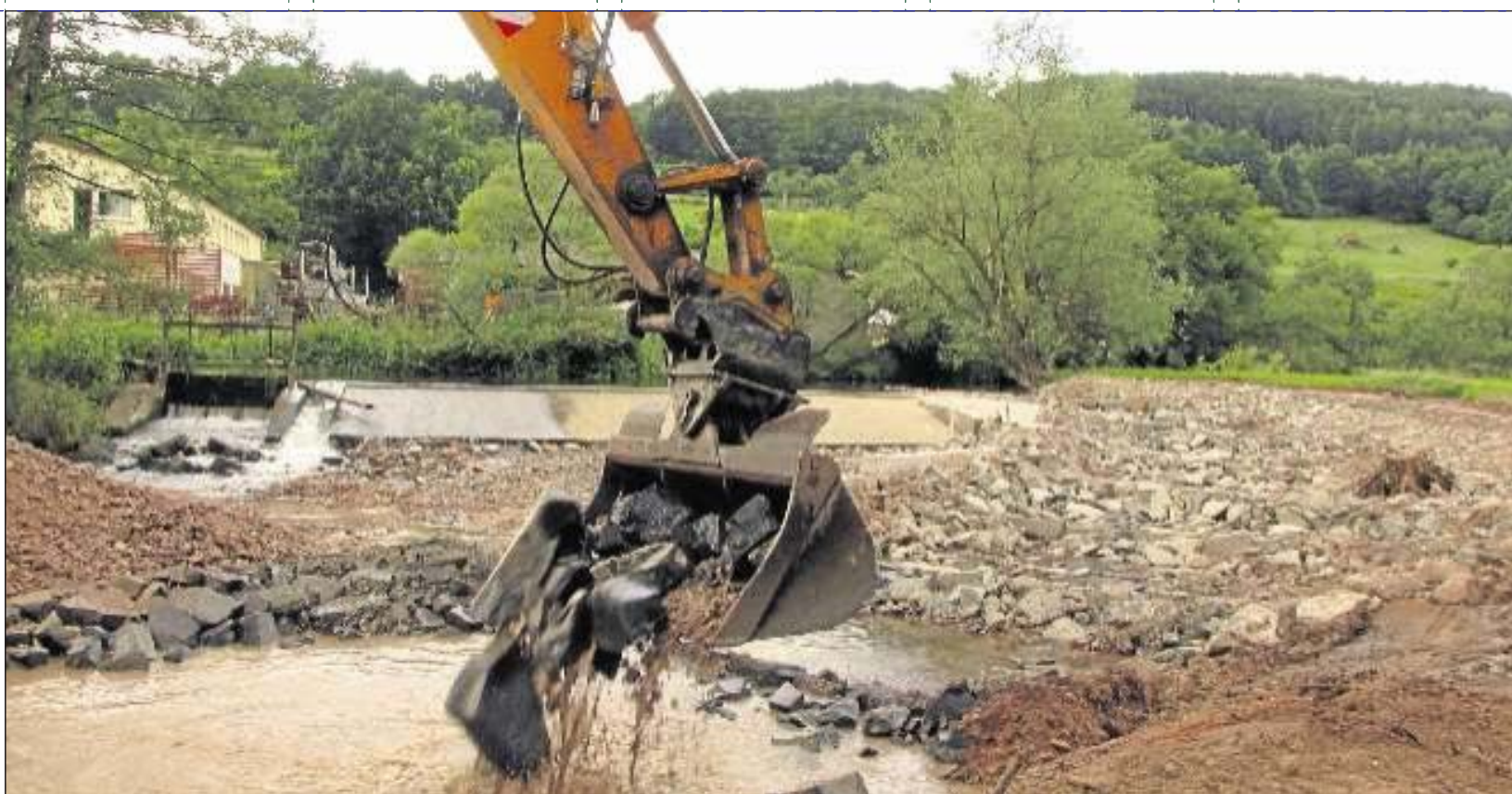
Die Fischaufstiegshilfe am „Fußschen Wehr“ in der Altengronauer Sinn nimmt Gestalt an. Das alte Wehr (Mitte) ist derzeit trockengelegt. Rechts entstehen die Becken des Umgehungsgerinnes, die durch Betonelemente vom Wehr getrennt sind und nun mit Basaltsteinen und alten Wurzelstöcken modelliert werden. Foto: Brigitte Betz
